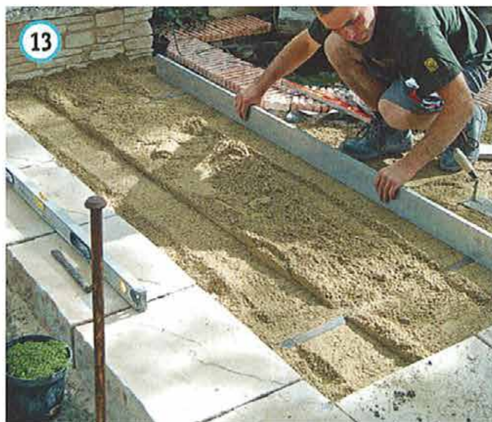
ÉTAPE 13 : PRÉPARATION DU SUPPORT
