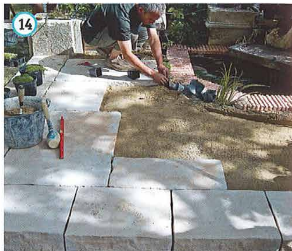
ÉTAPE 14 : POSE DES DALLES DE PIERRE
